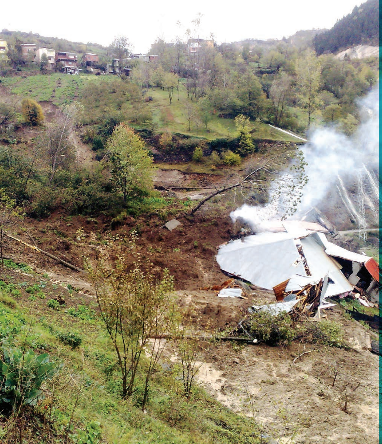
Trabzon Çal-Çığdemirli Köyü Heyelanı
