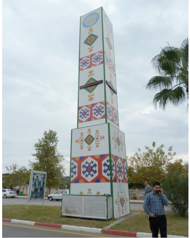
Şekil 1.2 Totem şeklinde kamufle edilmiş bir baz istasyonu (içinde 3 GSM'in de antenleri var.)
