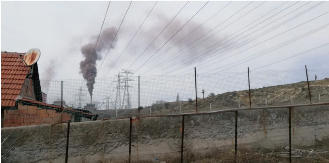
Şekil 40.3 Çevre Yatırımını Yapmadan Çalışan Santraller (Seyitömer Termik Santrali/Kütahya)..
