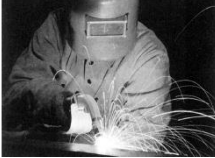
Şekil-10.7: Kaynak operasyonu.
