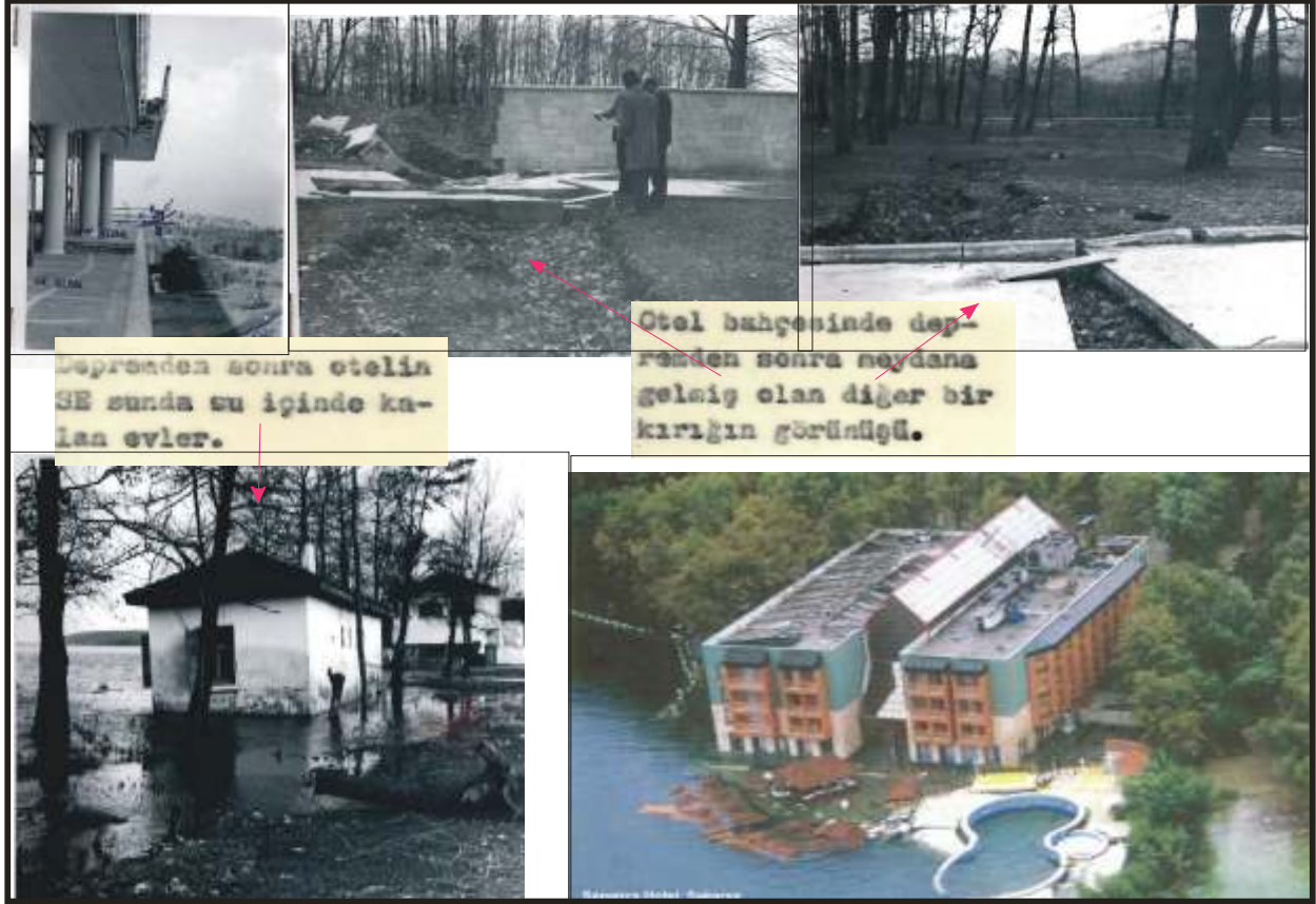
Şekil 1. Sapanca Vakıf Otelinin ve civarındaki alanın, 22 Temmuz 1967 depreminden aldığı hasarlar ve zemin deformasyonları, 25.03.1968 tarihli Jeolojik Etüt raporunda AİGM mühendisi Jeolog Ziya Barut tarafından anlatılmaktadır. Sonuç kısmında ise, binada alınacak tedbir, tamir ya da güçlendirmenin, kısa ve uzun vadede tekrarlayan depremlerle bir fayda getirmeyeceğini belirtmektedir. Siyah – beyaz resimler 1967 depreminin yol açtığı bina ve zemin deformasyonlarını, renkli resimler ise 17 Ağustos 1999 depreminden sonra ağır hasara uğrayarak yan yatan ve Sapanca Gölüne kavuşan, daha sonrada yıkılan Vakıf Otelini göstermektedir.
