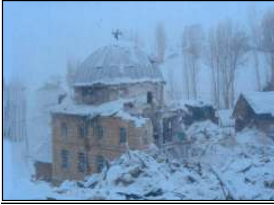
Şekil 203. Bayburt - Merkez - Üzençi köyünde meydana gelen çığ olayı.
