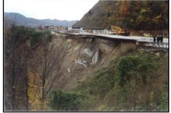
Şekil 218. Düzce (12.11.1999) depremi sırasında oluşan heyelan.
