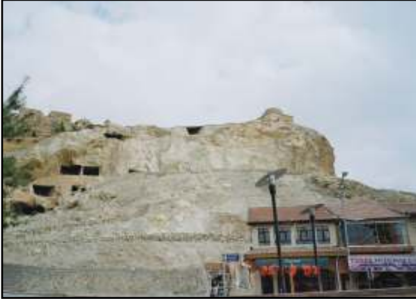
Şekil 179. Nevşehir - Ürgüp ilçe merkezinde meydana gelen kaya düşmesi olaylarının (a) ve islah sonrası (b) görünümü.
