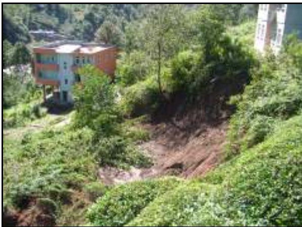
Şekil 124. Artvin - Hopa - Yoldere Köyünde meydana gelen heyelan.
